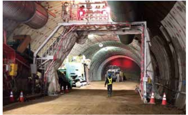
IDECの安全システムを導入した工事現場
