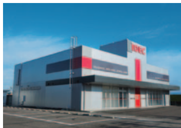
協調安全ロボットテクニカルセンター
