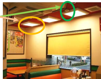
窓側に取り付けられた照度センサ
